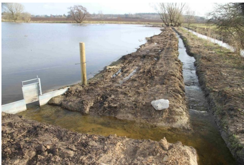
Foto 1. Et af de nye justerbare afløb fra gedde-engen kort efter etableringen i medio marts 2024 ved moderat vandføring. Afløbet føres via en kort kanal ud i den nye kanal, som løber parallelt med den eksisterende vandløb/kanal (Mejerigrøften), der anes yderst til højre i billedet.
